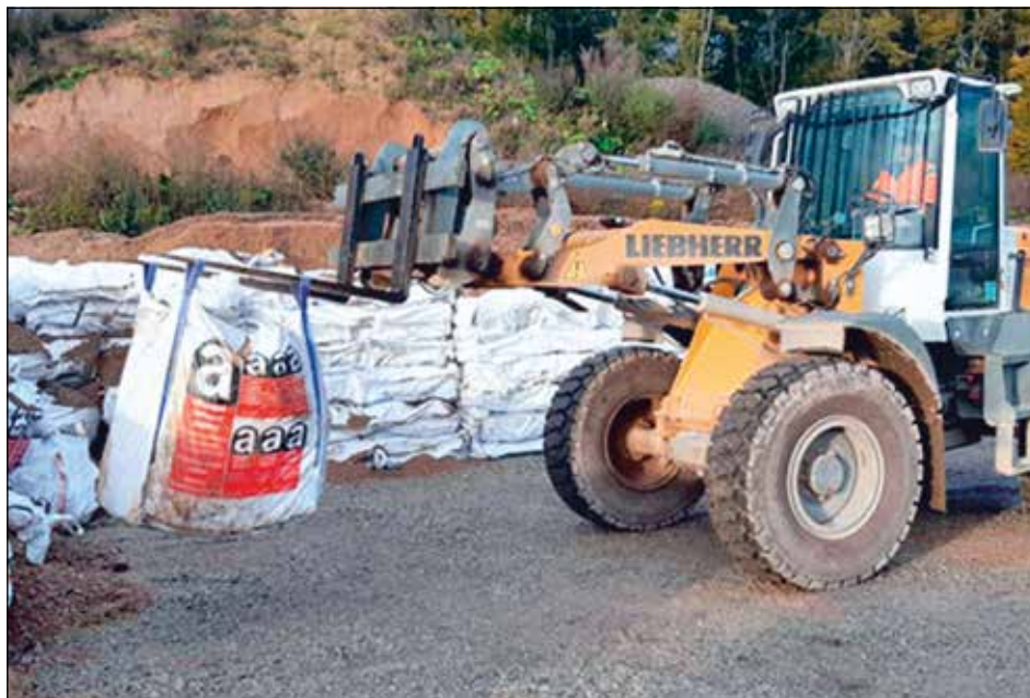
Einbau von Asbest in speziellen Big Bags auf der Deponie Unter Kaltenbuch: Für die Deponierung dieses Materials gelten besondere Regeln.
